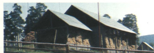
Fig. 10. Depozitul de fân al hergheliei Lucina (foto original)
