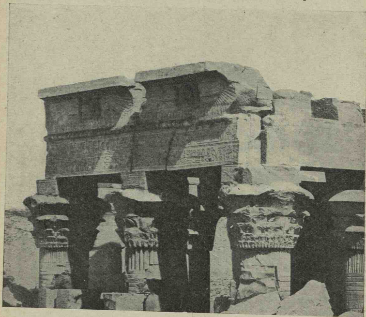
Fig. 201. — Entablement au-dessus d'une porte du temple (Kom-Ombos ; photographie BEATO).
