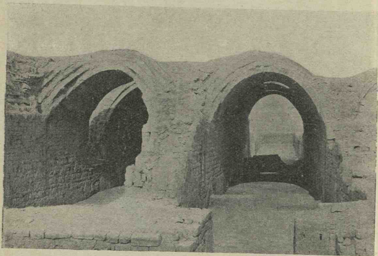
Fig. 203. — Magasins du Ramesseum (photographie de M. V. DE MESTRAL-COMBREMONT).
