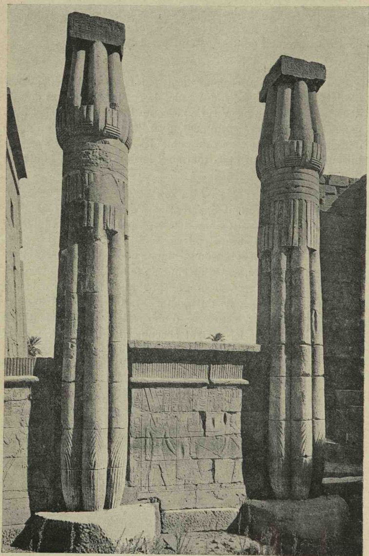
Fig. 60. — Murs d'entrecolonnement d'époque saïte (d'après JÉQUIER, Temples ramessides et saïtes , pl. LXXX).
