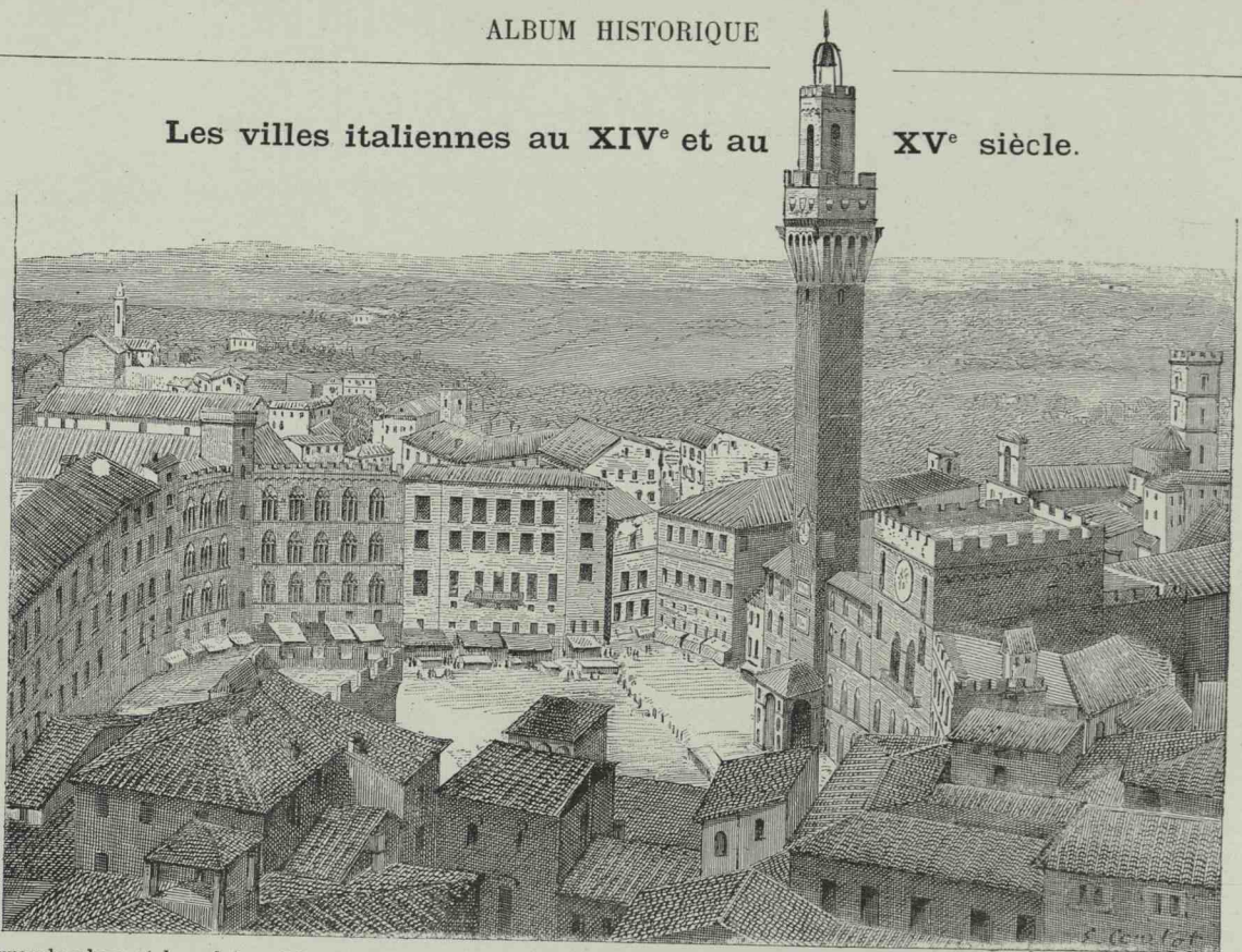
La grande place et le palais public de Sienna . Ce monument fut construit de 1295 à 1327 par les architectes Agostino et Angelo de Sienna. La grande tour ne fut achevée qu'en 1345.
