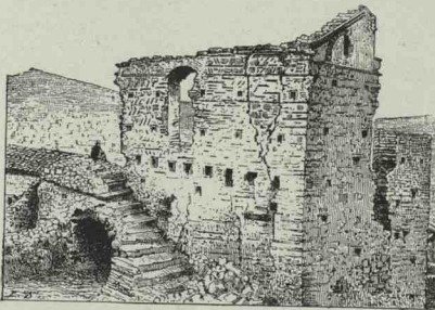
Maison byzantine du XIV e ou du XV e siècle à Mistra (Grèce); dans les trous que l'on voit sur les murs, s'accrochaient les poutres supportant l'avant que l'on voit figuré sur la miniature ci-dessus (d'après une photographie).
