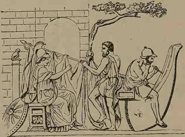
Construirea corăbiei Argo
