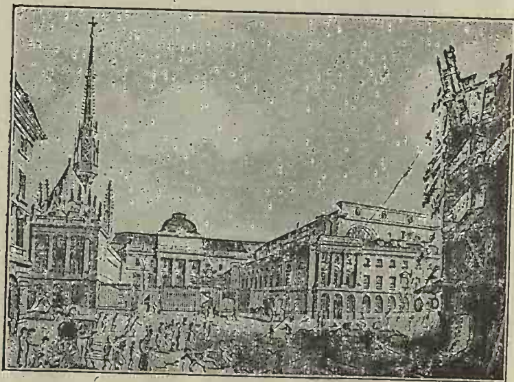
LE PALAIS DE JUSTICE ET LA SAINTE-CHAPELLE A LA FIN DU XVIII e SIÈCLE; LA FLÈCHE, CONSTRUITE SOUS LOUIS XIII, FUT DÉMOLIE EN 1791.
