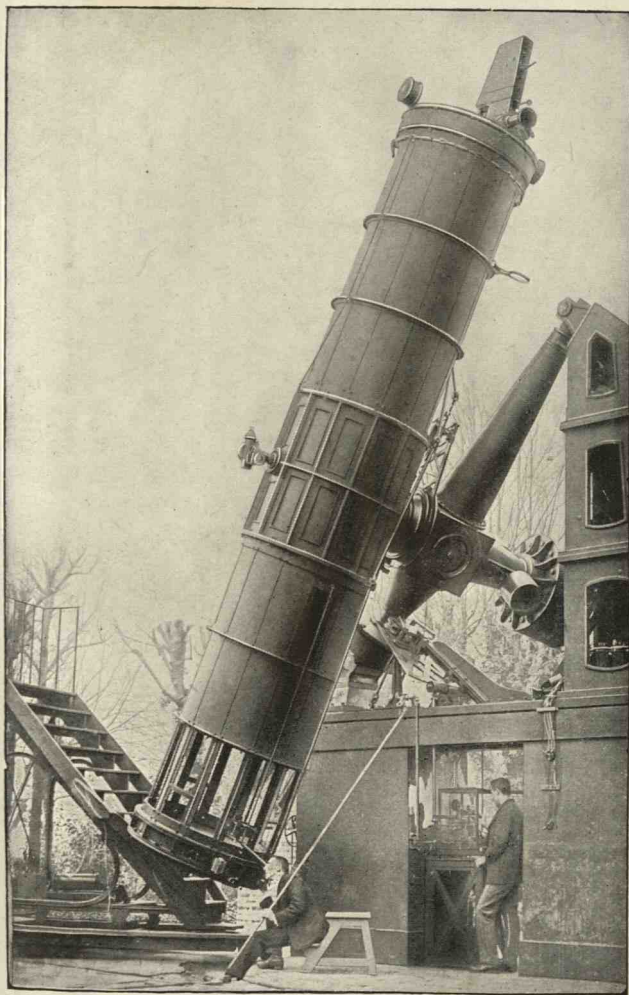
GRAND TÉLESCOPE A MONTURE ÉQUATORIALE DE L'OBSERVATOIRE DE PARIS.
