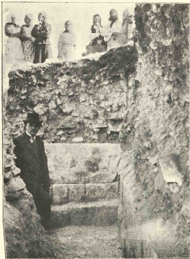
Fig. 2. — Laturea de NE. Incheierea turnului patrulater cu a doua curtină. Monumentul funerar creștin de pe pl. următoare, «in situ».
