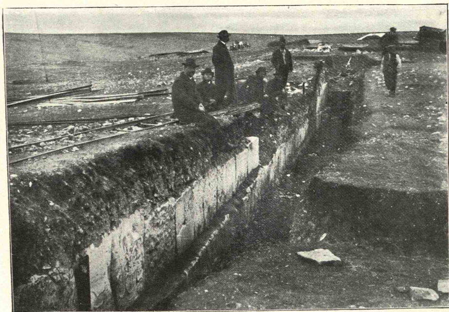
Fig. 2.— Laturea de NV. Prima curtină, dela turnul rotund de N până la turnul din stânga al porții de NV.
