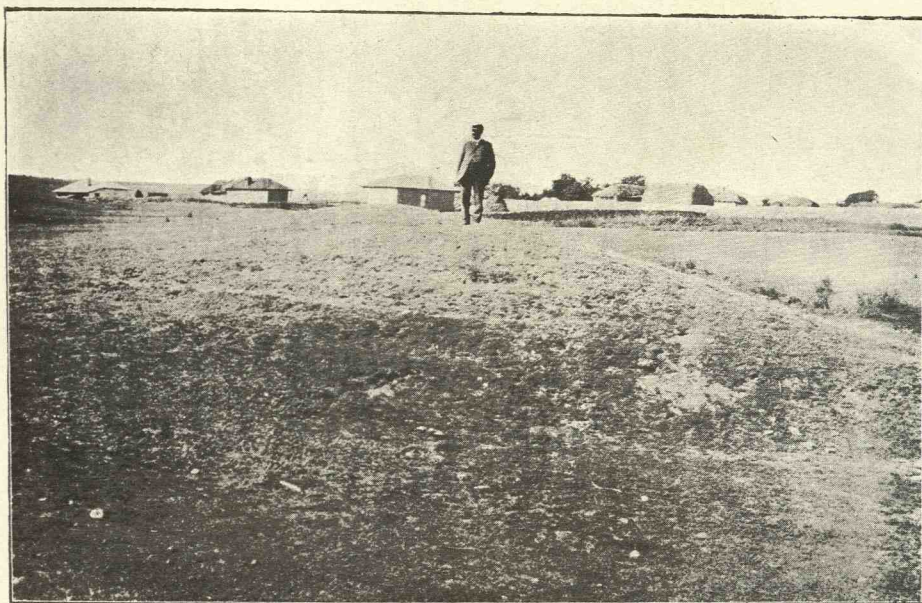
Fig. 1. — Valul cetății paralel cu latura NV.
