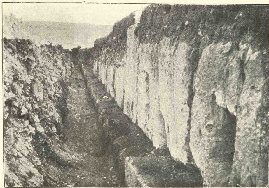
Fig. 2.—Latura de NE. Curtina dintre turnul de colț la E și turnul patrulater din mijloc.
