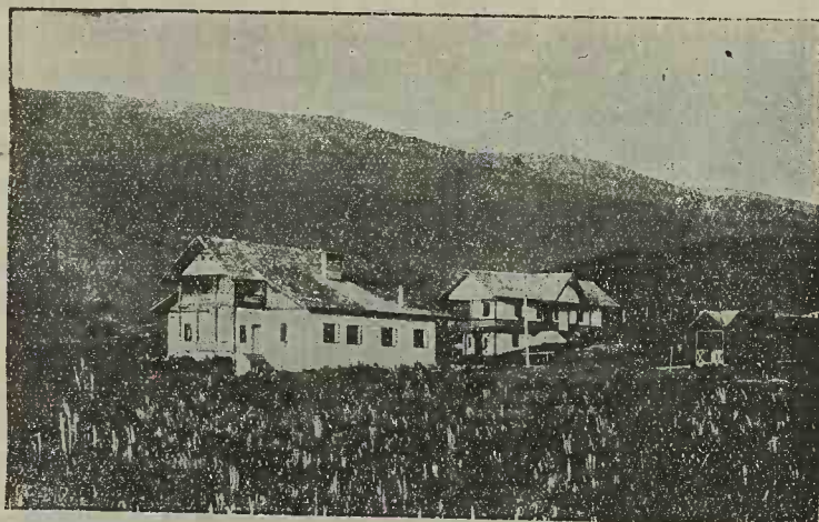
Casa de vânătoare a M.S. Regelui la Bahna Rusului, Muscel
