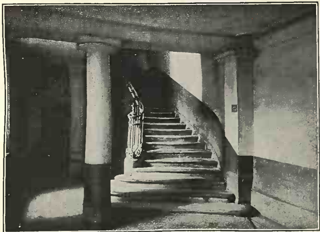
ANCIEN HOTEL D'ORVILLERS
