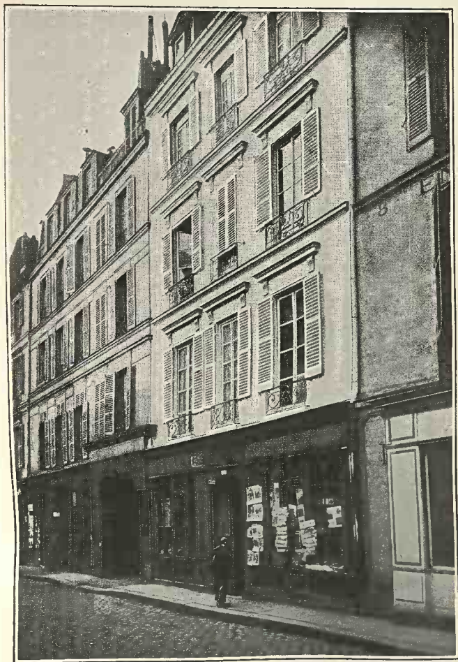
MAISON HABITÉE PAR LA COMTESSE DE LA MOTTE Rue Neuve-Saint-Gilles, aujourd'hui rue Saint-Gilles, n° 10.
