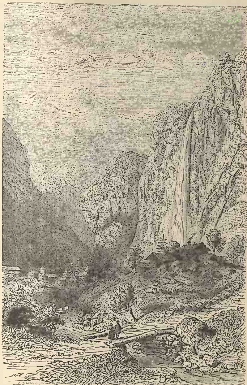
Fig. 125. Cascade du Stablach, en Suisse.
