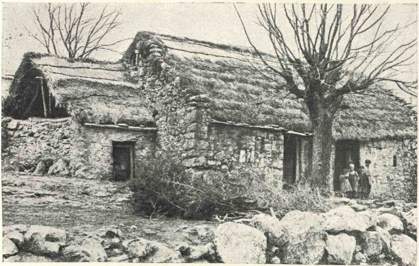
Fig. 18. Veche casă țărănească (Fotografie de M. Gortan, Pisino).
