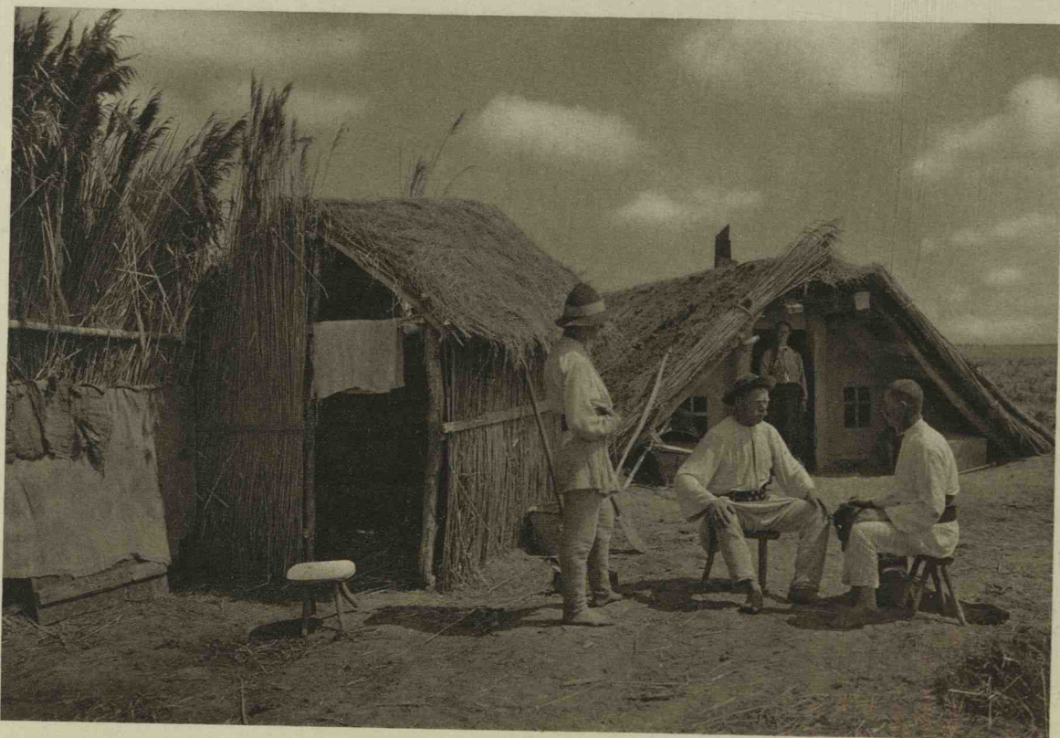
Obdach für Feldarbeiter Shelters for labourers
