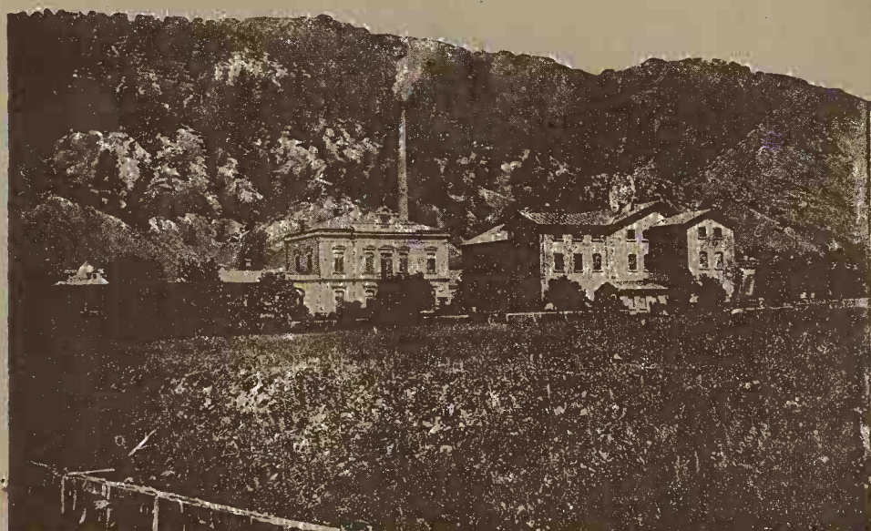
Fabrica de Hârtie din Câmpulung
