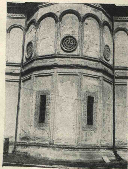
Fig. 296. — Détail de façade
