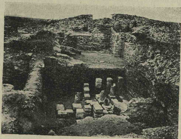
Fig. 58. Vederea caloriferului (HYPOCAUSTUM) uneia din odăile BĂILOR ROMANE dela HISTRIA, desgropat și întărit cu ciment de noi în 1916; azi nu mai există fiind distrus de Bulgari în vremea războiului.
