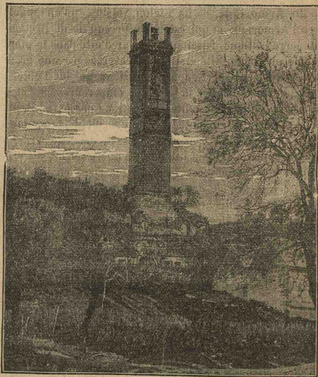
Pile de Cinq-Mars 1 (Indre-et-Loire).
