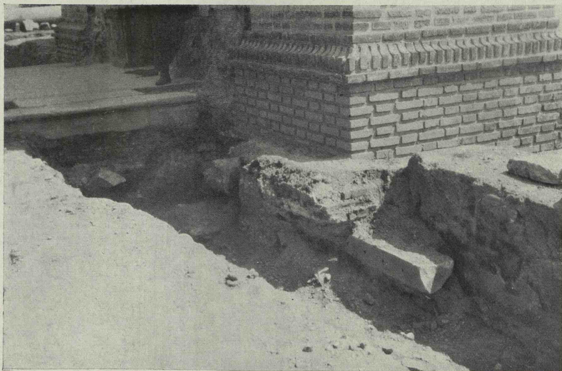
Fig. 87 și 88. — Biserica Curtea Veche din București. Detaliu de zidărie reconstituită.
