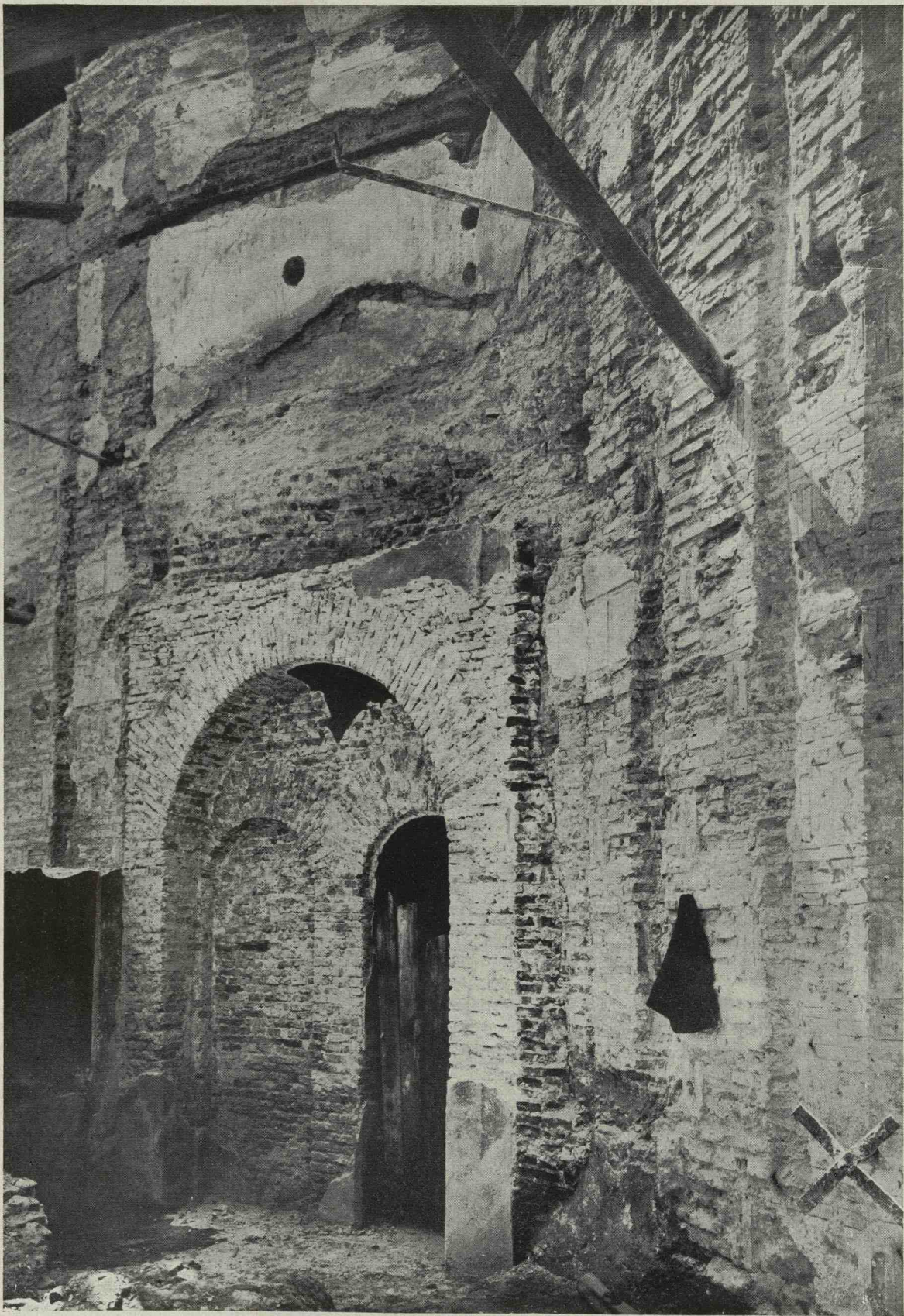
Fig. 84. — Biserica Curtea Veche din București. Detaliu de zidărie în timpul restaurării.
