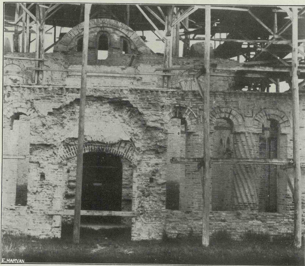
Fig. 116.— Vedere a vechei Mitropolii din Târgoviște în timpul dărâmării ei de către arhitectul A. Lecomte du Nouy.
