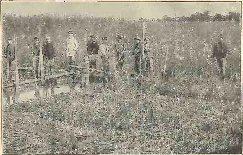
Fig. 2. „Plaur“ in den Seen des Donaudeltas. In dieser schwimmenden Rohrschicht wird ein Kanal durchstochen.
