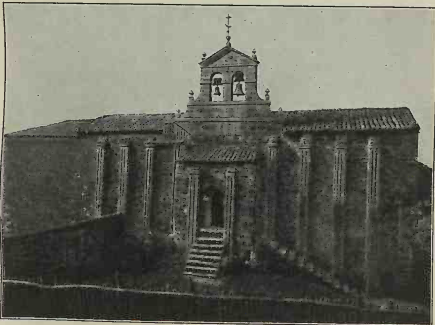
Abb. 129. Sta. Maria de Naranco. Außeres. (Phot. J. Laurent y Cie., Madrid.)
