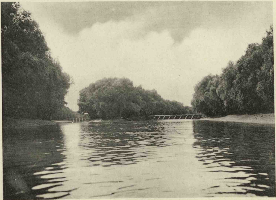
DIE GÄRLA FILIPOI. DIE FISCHLEUSE UND DAS FISCHWEHR.
