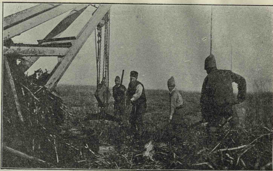
Fig. 19.—Săparea canalului dela Caciatina cu Draga și cu Zastupurile în regiunea Plaurului.
