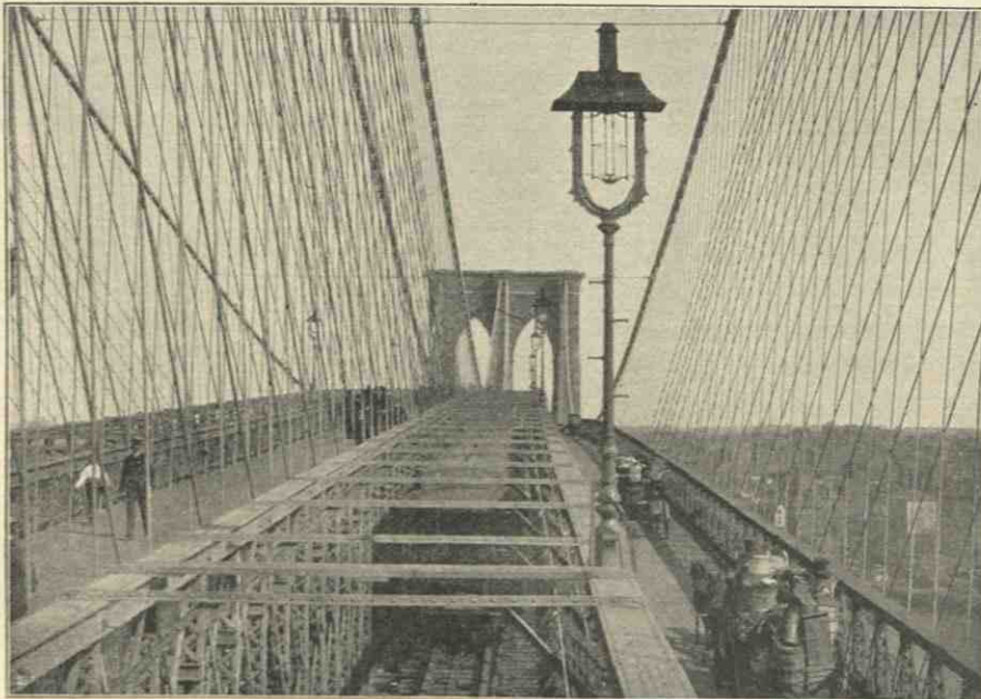
Fig. 11. Röbbling: Draht-Brücke zwischen Neuyork und Brooklyn. Nach Phot. v. J. Kuhn, Paris.
