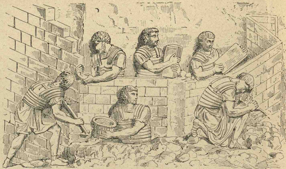
560. Construction d'un castellum par les légionnaires (Hist. rom., IV, p. 762; col. Traj.).
