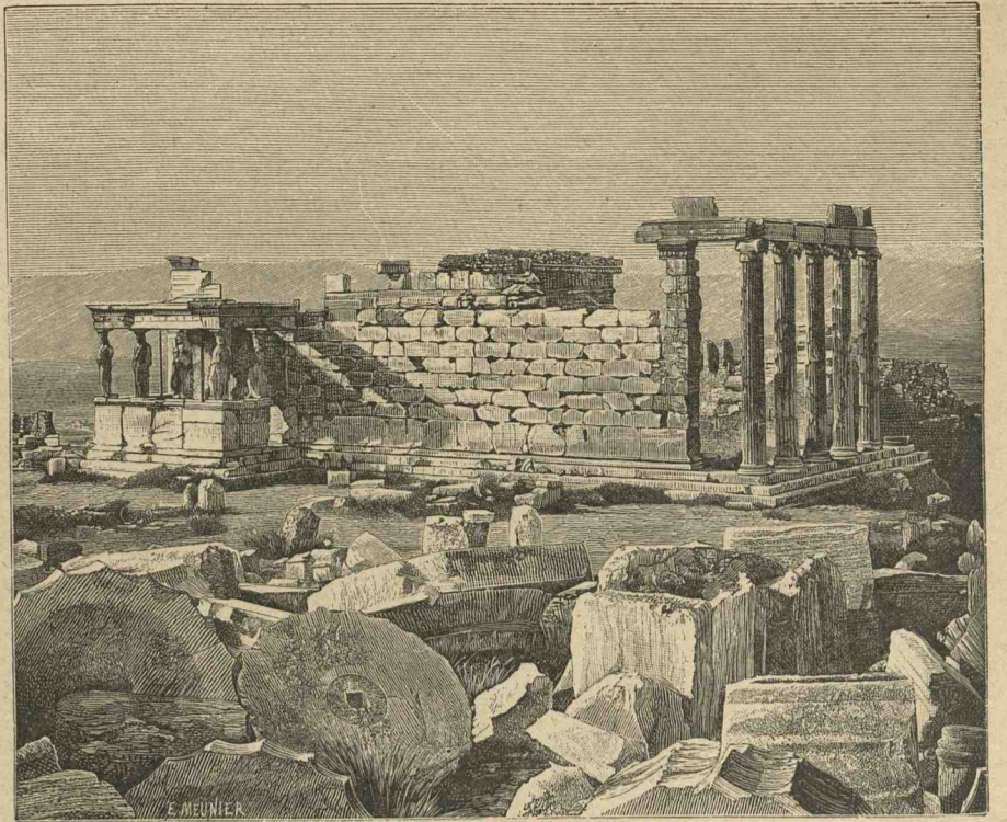
122. Érechthéion. — Façade Sud-Est. — (Hist. gr., II, p. 220.)
