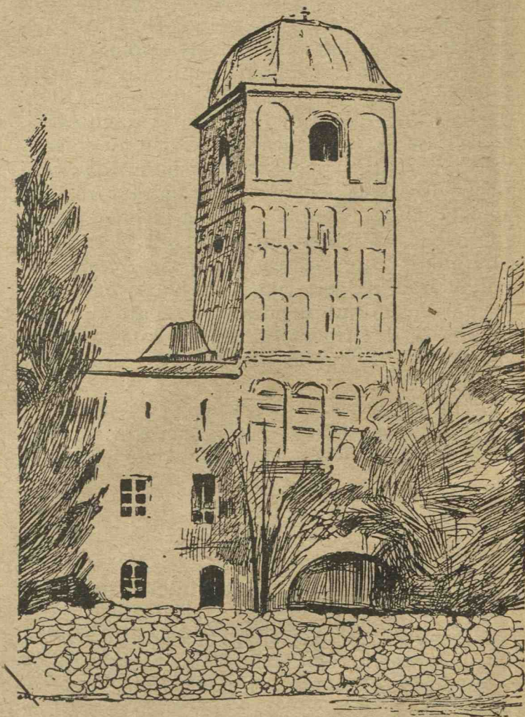
Fig. 13. Turnul și o parte din zidul de încunjur al mănăstirii Câmpulungului.
