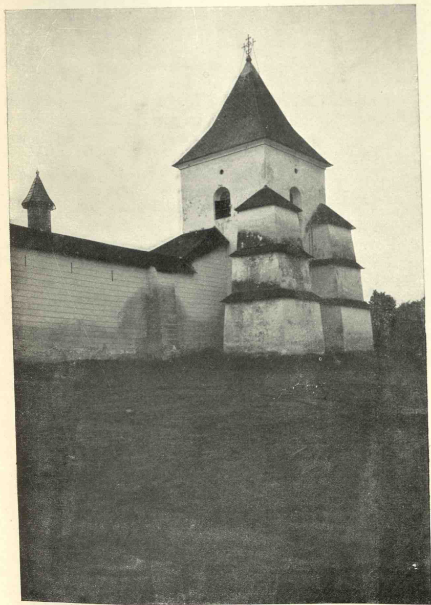
Fig. 61. — Murs d'enceinte du couvent de Sucevița, fondation des Movilă.
