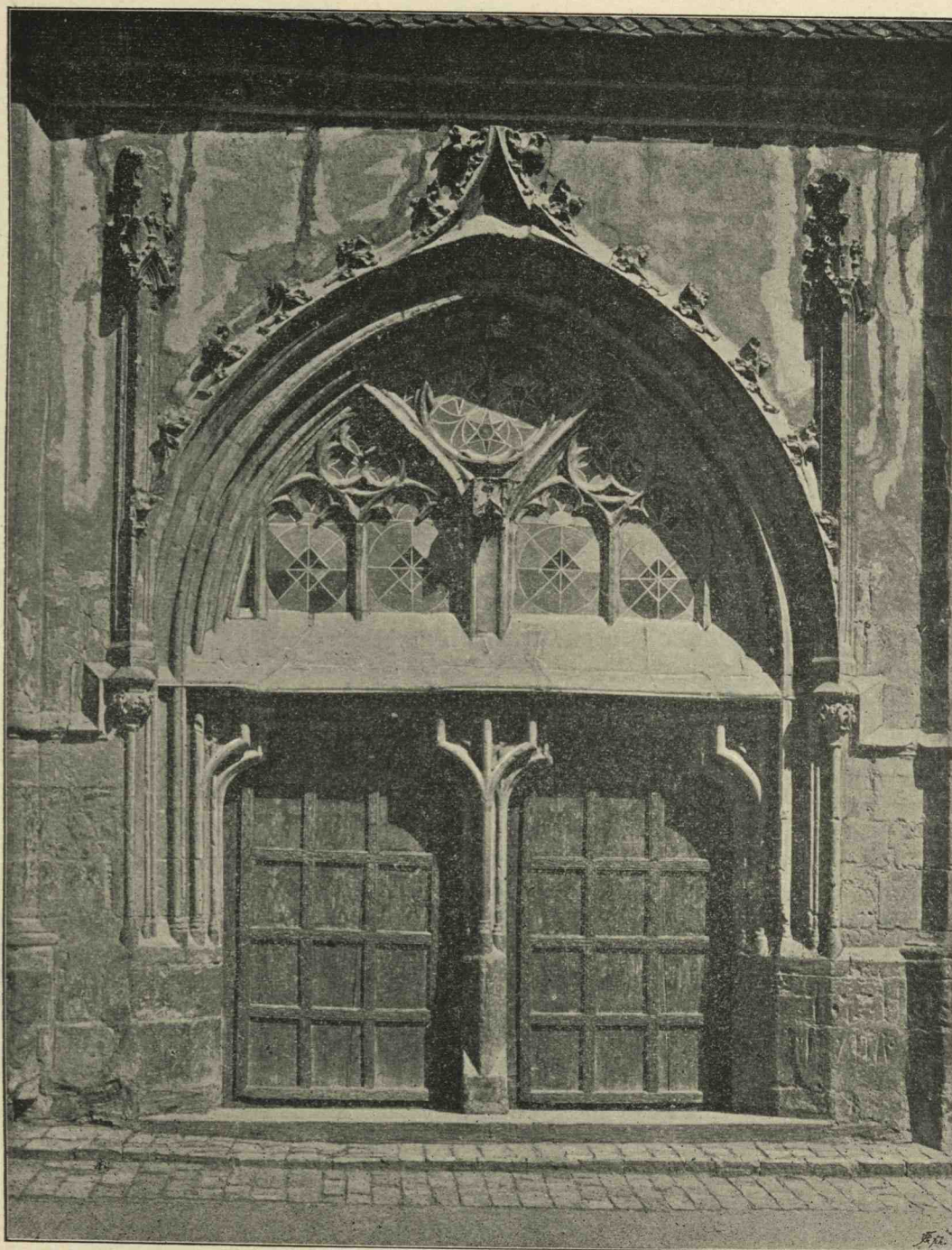
5. Äußeres Portal der Vorhalle auf der Südseite.
