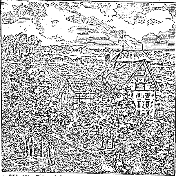
Abb. 121. Bodmers Haus in Zürich, die gastliche Dichterherberge.
