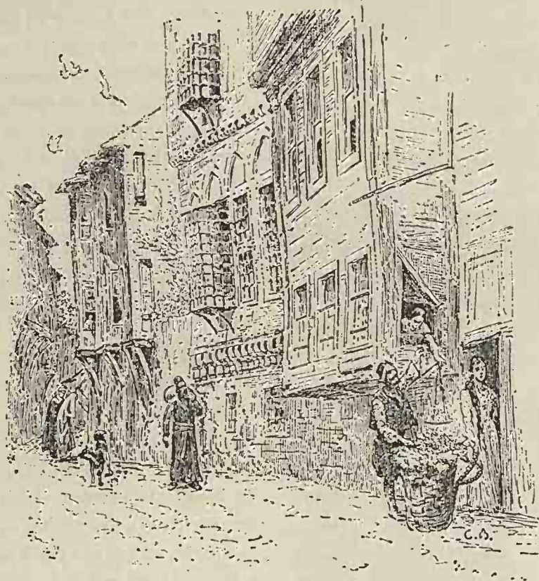
Façade d'une maison.
