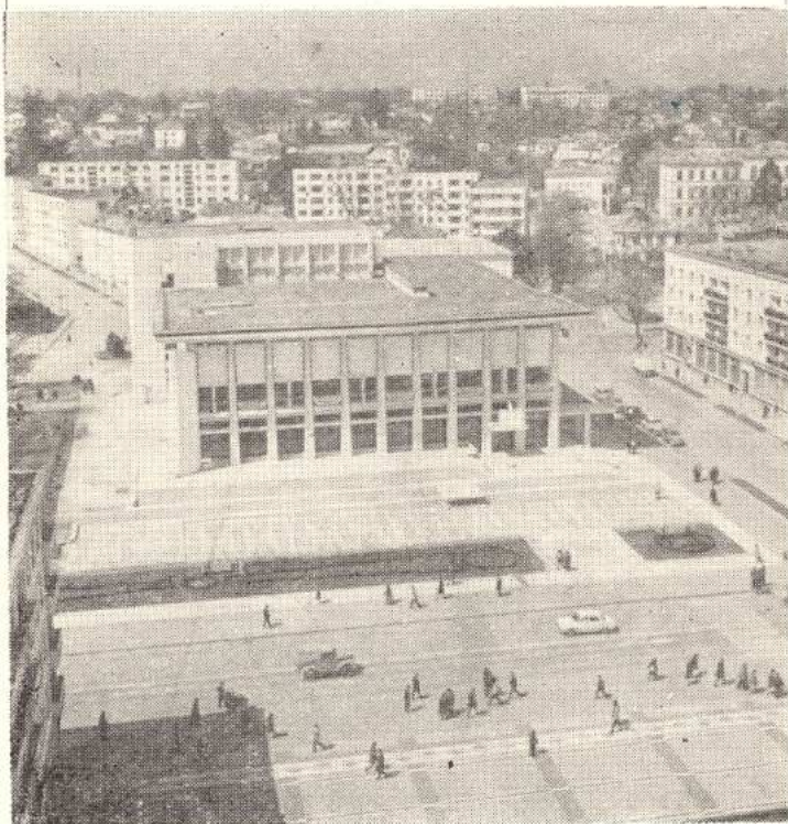
Casa de cultură a Sindicatelor din Suceava
