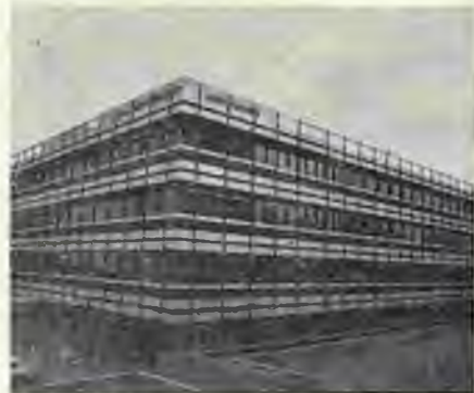
Clădirea pentru birouri construită de ARCOM la Wiesbaden (R.F.G.)
