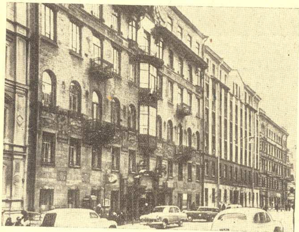
Clădirea unde a apărut primul număr al „Pravdei”.
