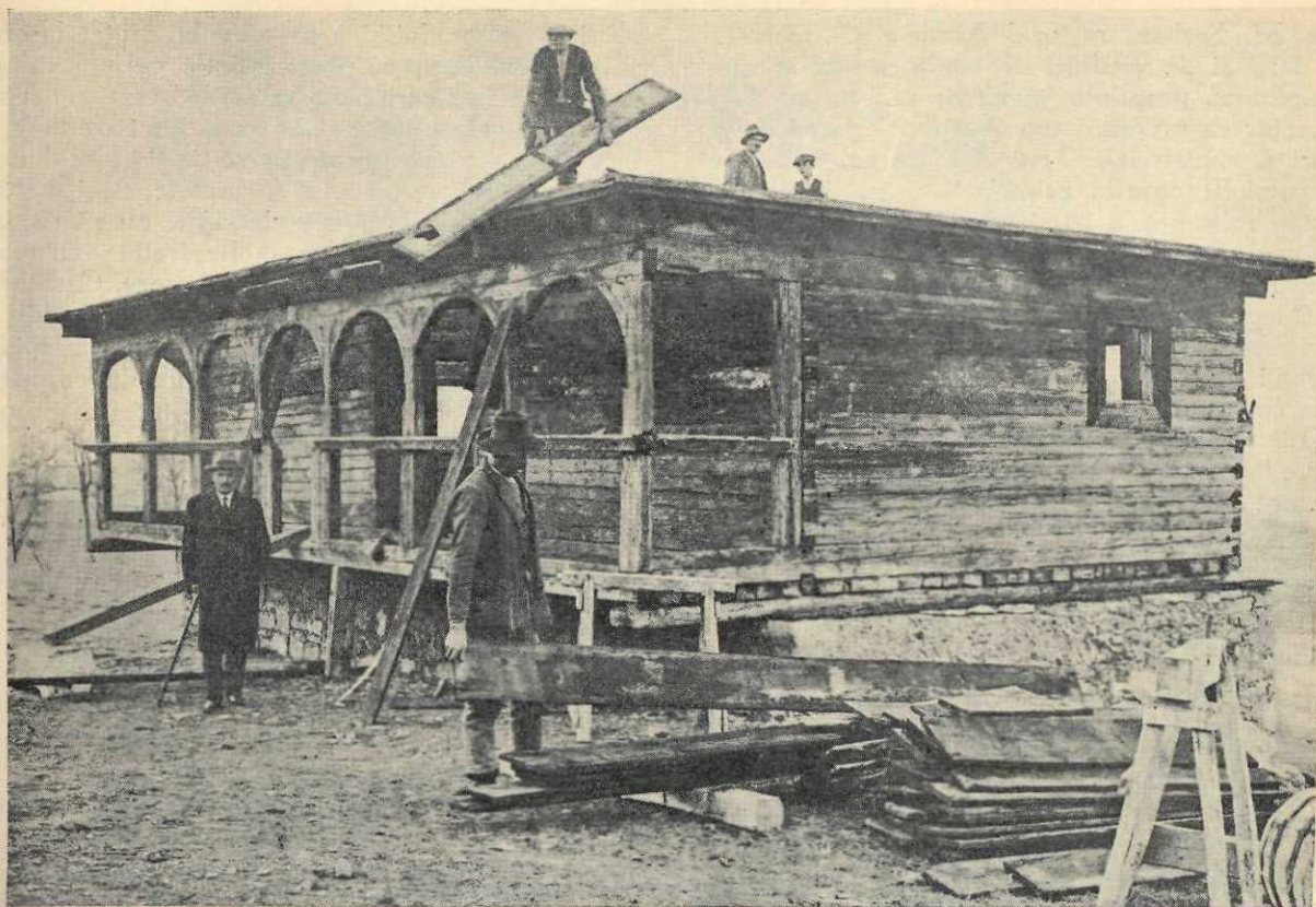
Casa Moțului, din Vidra, în construcție
