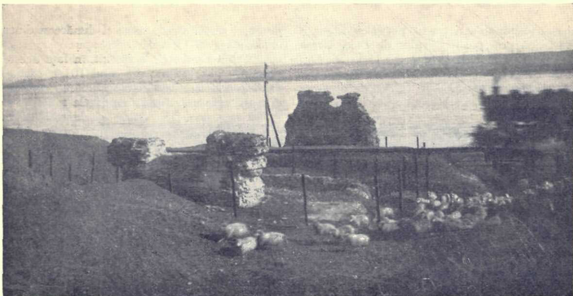
Zidul portalului și pila-culee dela capătul nordic al podului lui Traian
