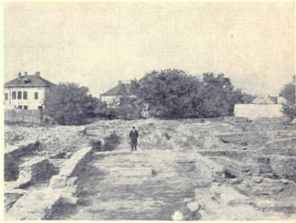
Fig. 70. — Privire din praetoriul lui Hadrian spre poarta decumană (înaintea săpăturilor din 1929)
