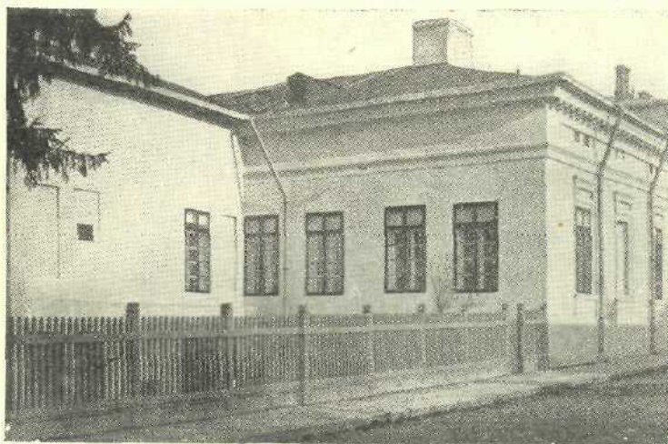
Aripa stângă, înainte și după reparație
