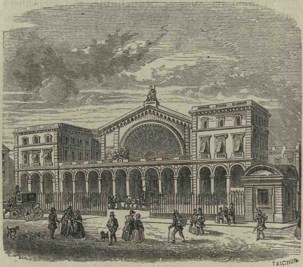
Fig. 114. — Vue extérieure de la gare du chemin de fer de l'Est, à Paris.
