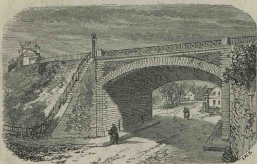
Fig. 54. — Pont biais près la gare de Rambouillet.
