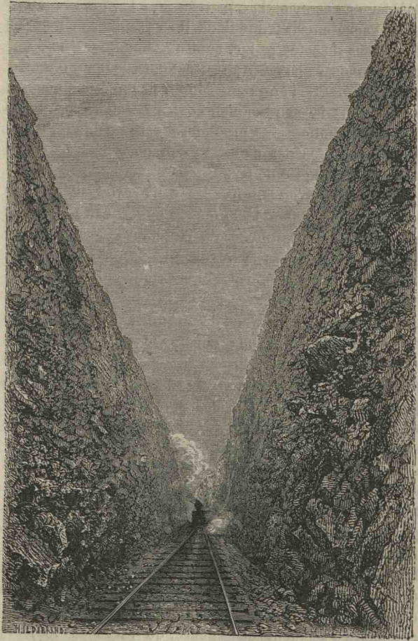
Fig. 21. — Tranchée de Bloomer (Californie) sur la ligne du Central Pacific .
