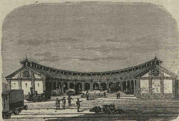
Fig. 107. — Remises pour locomotives.
