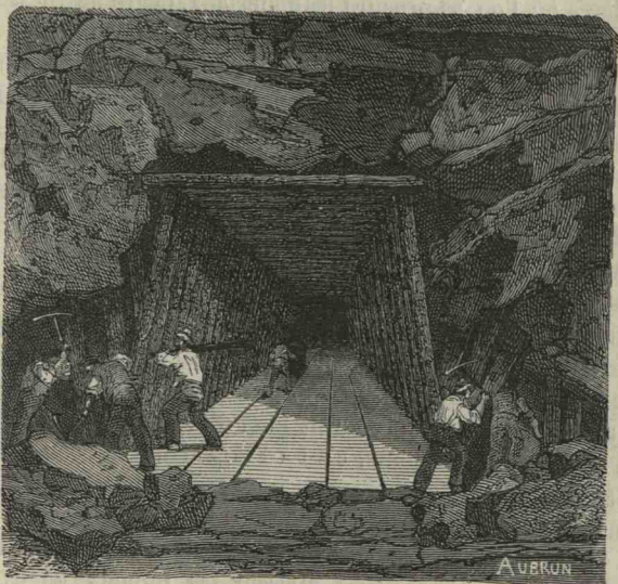
Fig. 27. — Travaux de construction d'un tunnel; charpente de la galerie provisoire.
