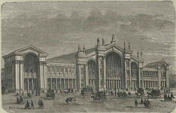
Fig. 115. — Vue extérieure de la nouvelle gare du chemin de fer du Nord, à Paris.
