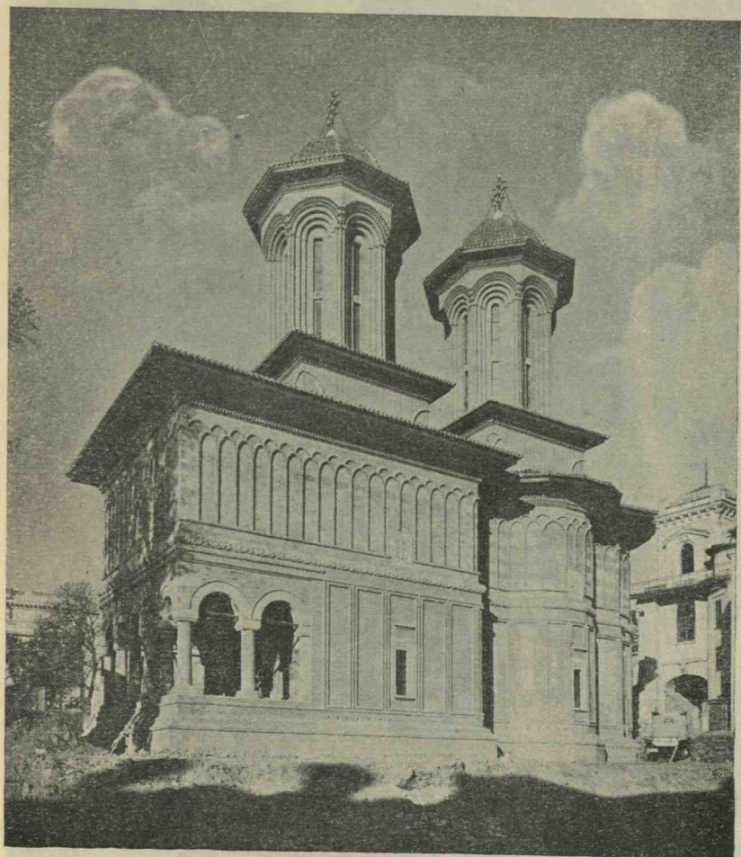
Biserica Crețulescu (după reparație).
