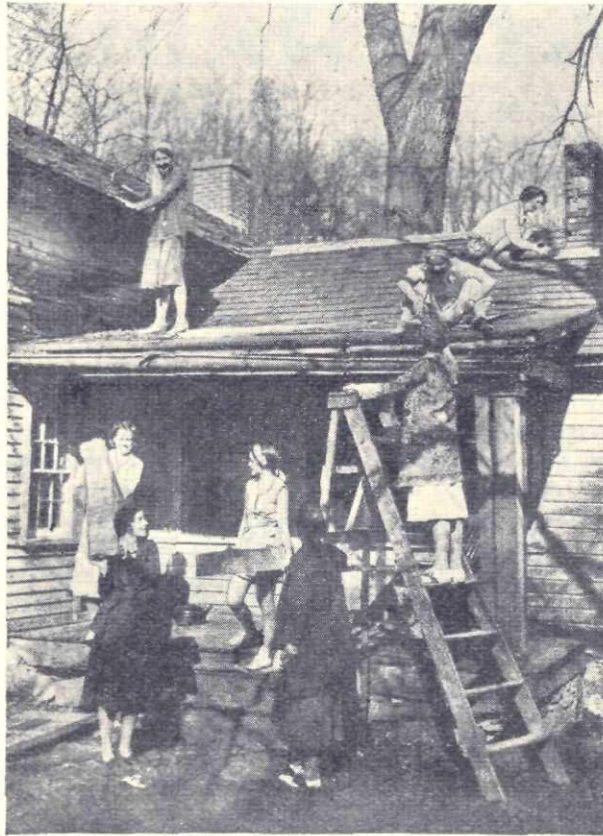
Repararea unui adăpost de vară la țară de membrele unui club dela Wells College în Aurora
