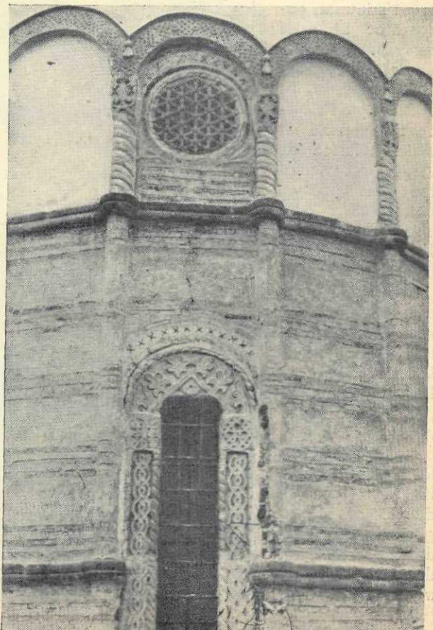
Mănăstirea Cozia-Vâlcea. Detaliu din fațada bisericii scoasă la iveală prin lucrările Comisiei Monumentelor Istorice,
