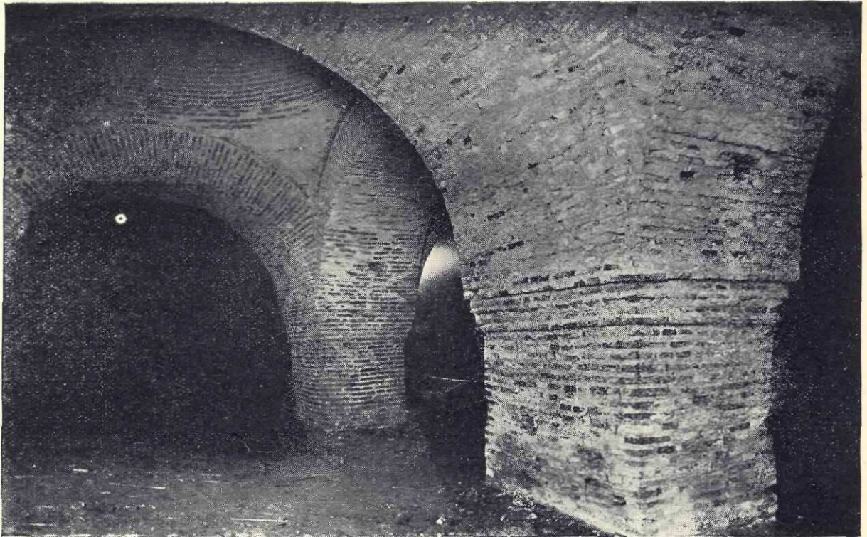
Sala boltită de sub vechiul Palat
