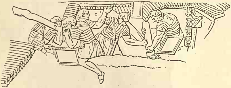
Fig. 172. — Soldats romains occupés à construire un agger ou retranchement. (D'après un ancien bas-relief.)
