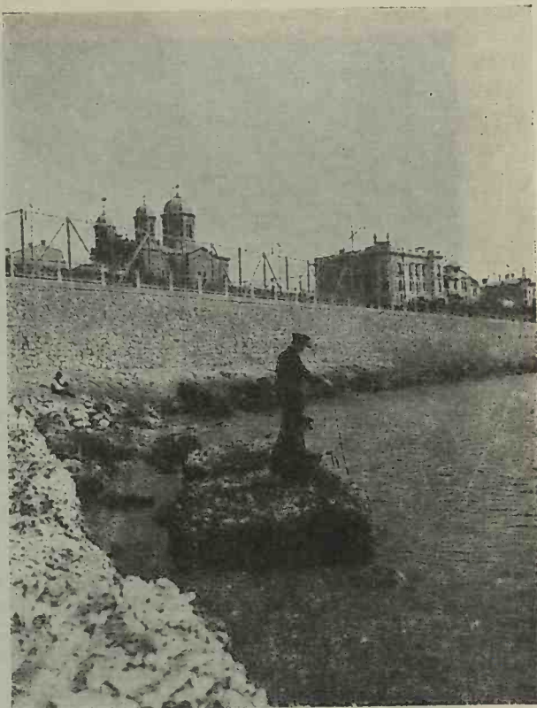
Fig. 50. — Fund de piatră cu bucăți de stânci neacoperite de apa mării dar împroșcate de valuri, cu o faună specială amfibie
