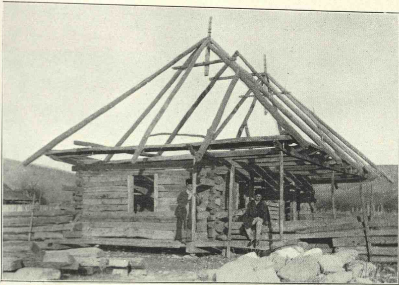
Abb. 52. Blockbau und Dachstuhl in Bumbesti (Gorj).
