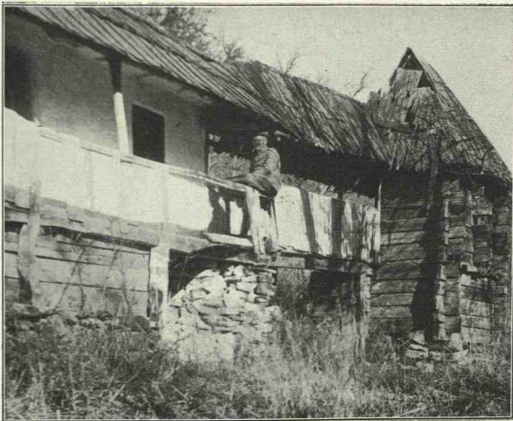
Abb. 68. Berghaus mit Abortturm in Bohlenbau bei Locurile (Gori).
