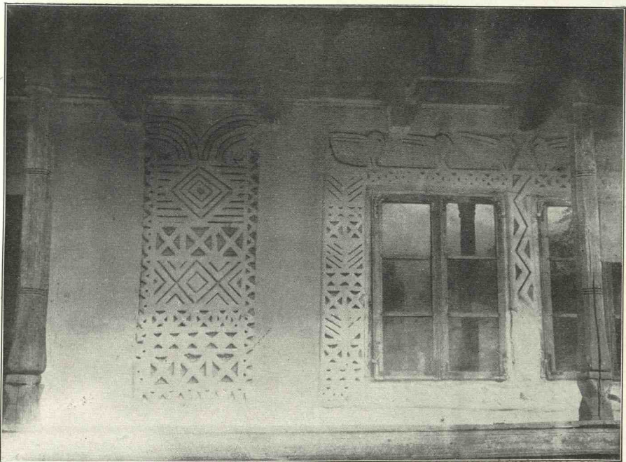
Abb. 66. Stuckverzierungen in Doicești (Dâmbovița).
