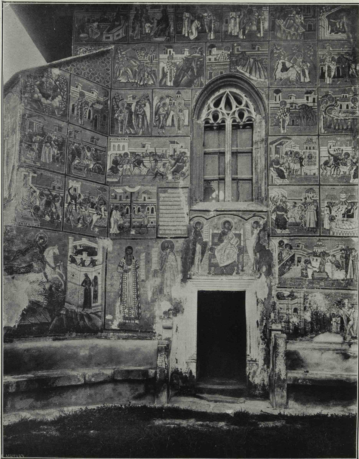
Fig. 353. Voroneț. Peretele sud din afară al pridvorului. (Fot. Bălan.)
