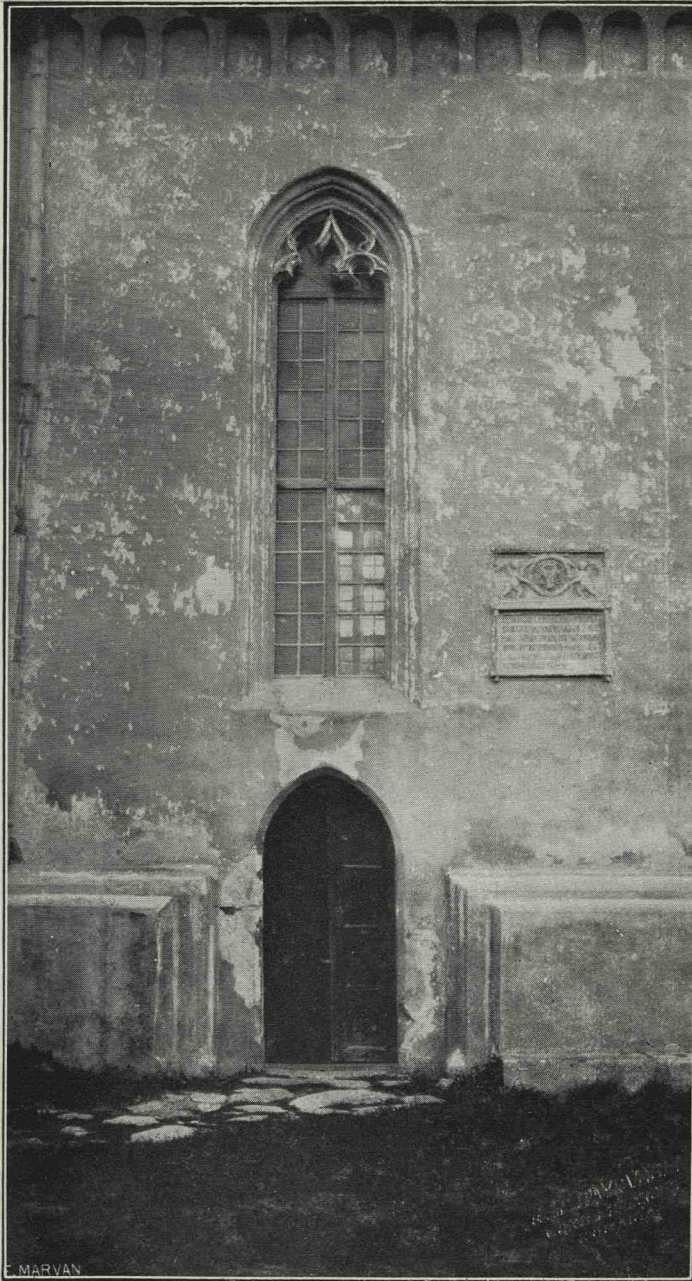
Fig. 47. Sf. Dumitru. Peretele sud al pronaosului văzut din afară (H.)
