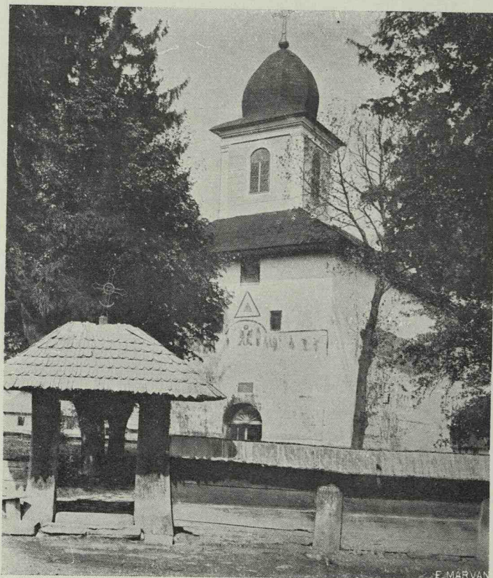
Fig. 37. Baia. Vedere înainte de restaurare. (C. M. I.)
