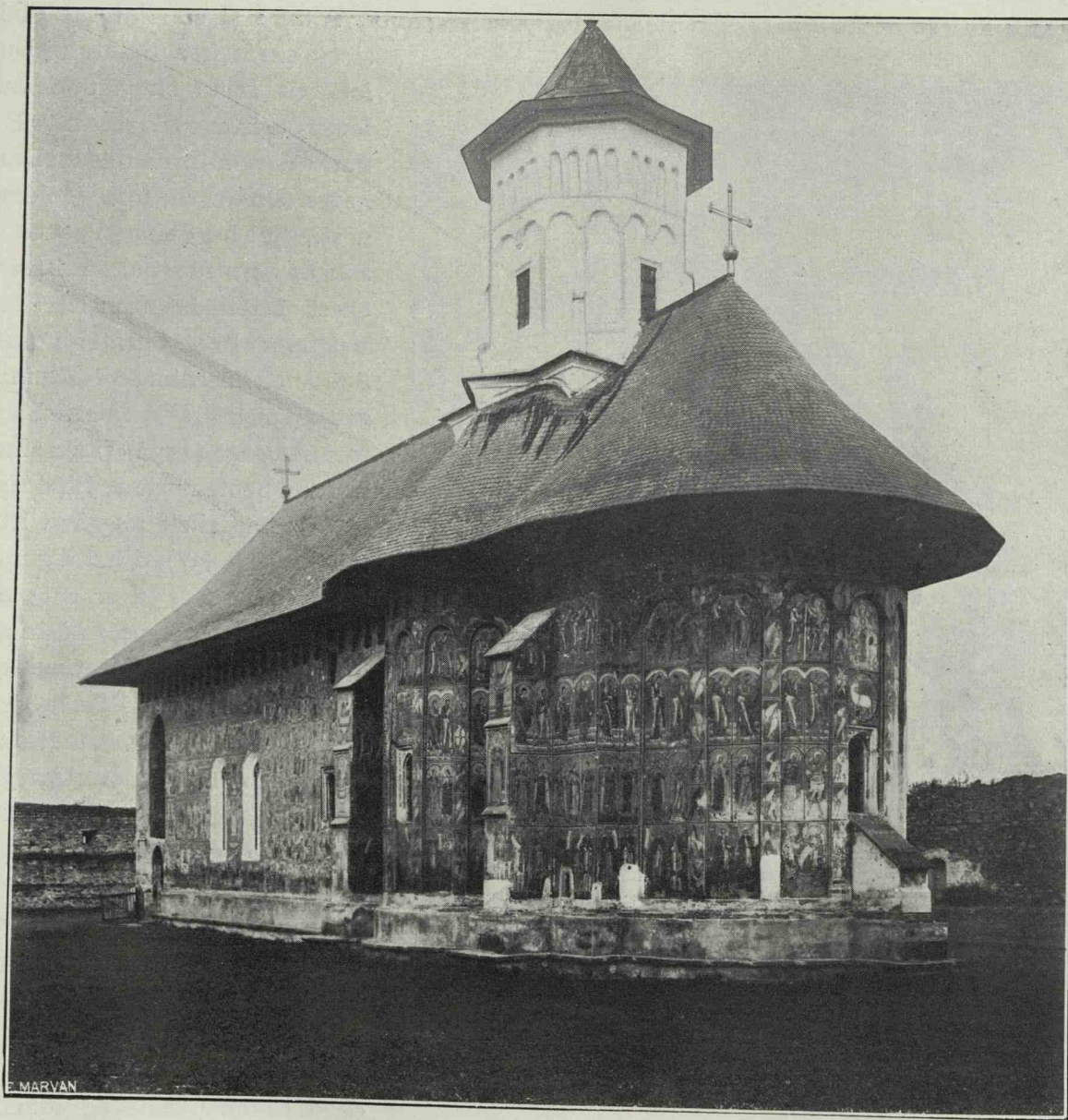
Fig. 30. Moldovița. Vederea spre altar. (H.)
