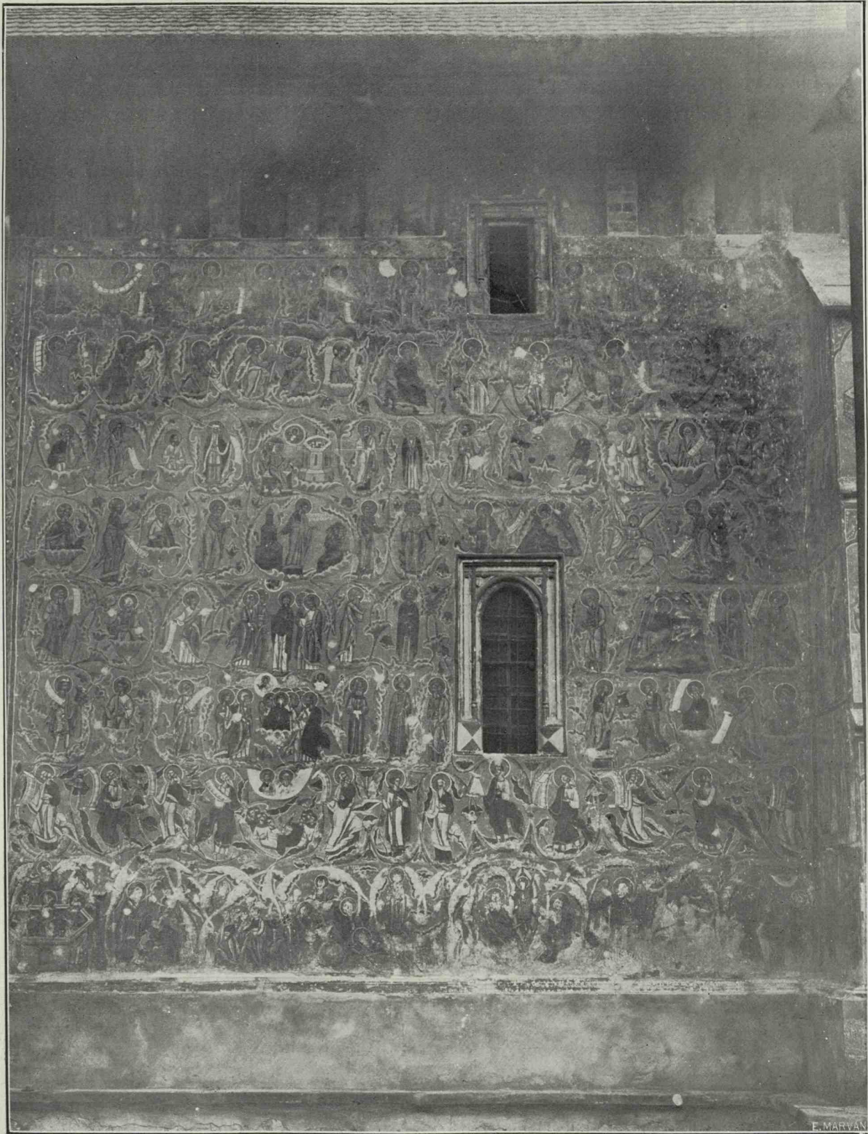
Fig. 28. Moldovița. Peretele sud al gropniței, văzut din afară (Fot. Bălan.)
