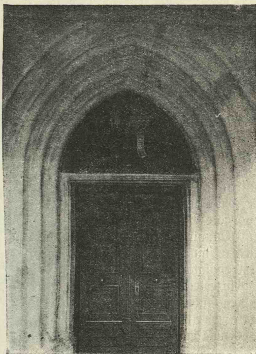
Fig. 161. Reuseni, Ușa exterioră
