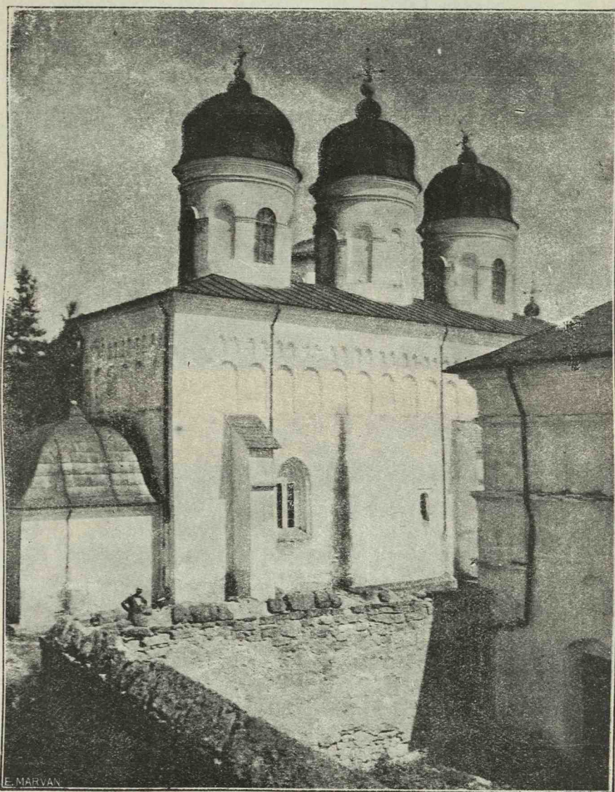
Fig. 172. Dobrovăț, Vedere din spre Sud-Vest
