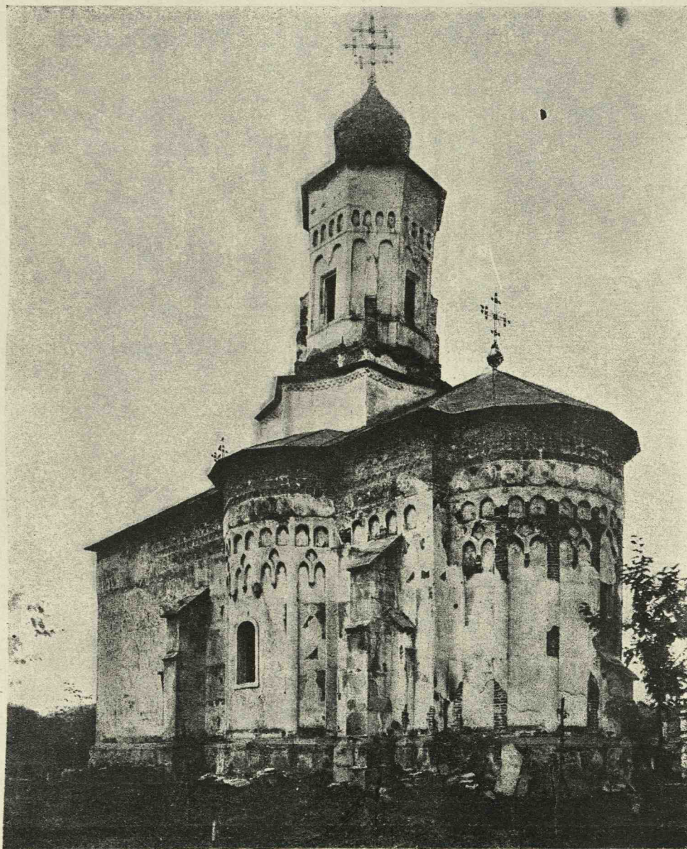
Fig. 62. Sf. Gheorghe, Hârlău, înainte de restaurare
