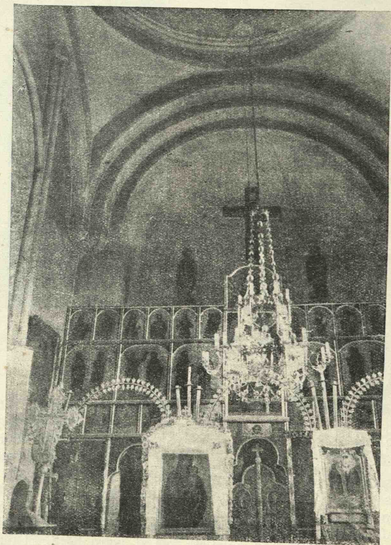
Fig. 165. Reuseni, Vedere în naos
